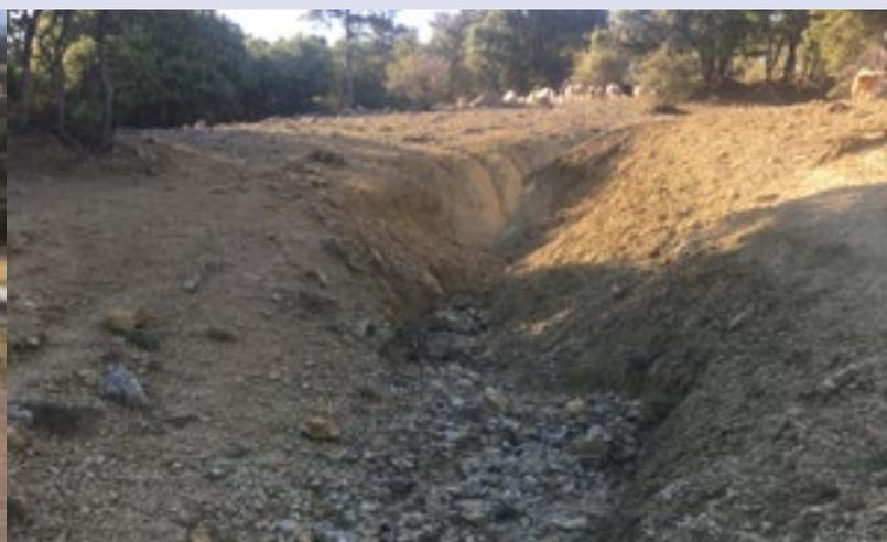
Figura 8 Erosión formando cárcavas en el camino
